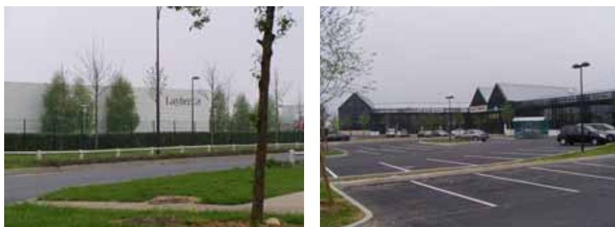
L'entreprise Lahver et le centre commercial sur le Parc d'activités des 3 Noyers
